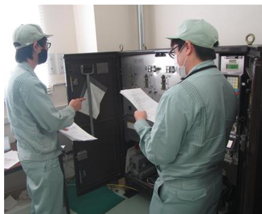
開閉器操作訓練の様子
